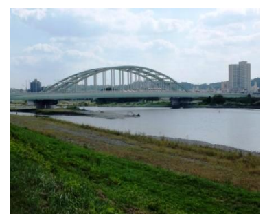
多摩川水道橋
